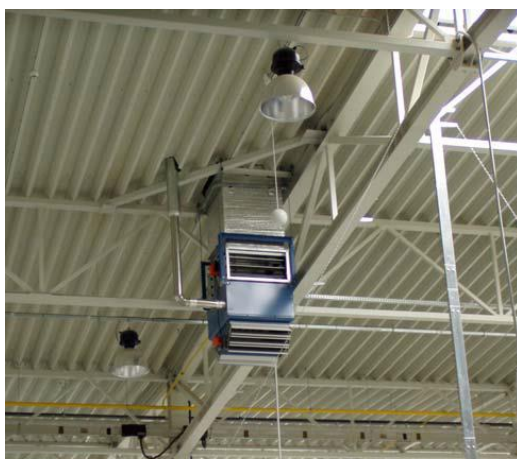
Obr. 5 Decentrálna vetracia a klimatizačná jednotka
