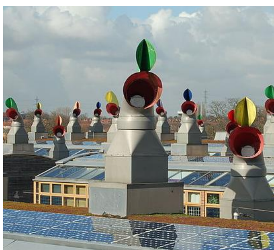
Obr. 3 Zvýšenie efektivity vetrania strešnými výustkami vzduchu [6]
